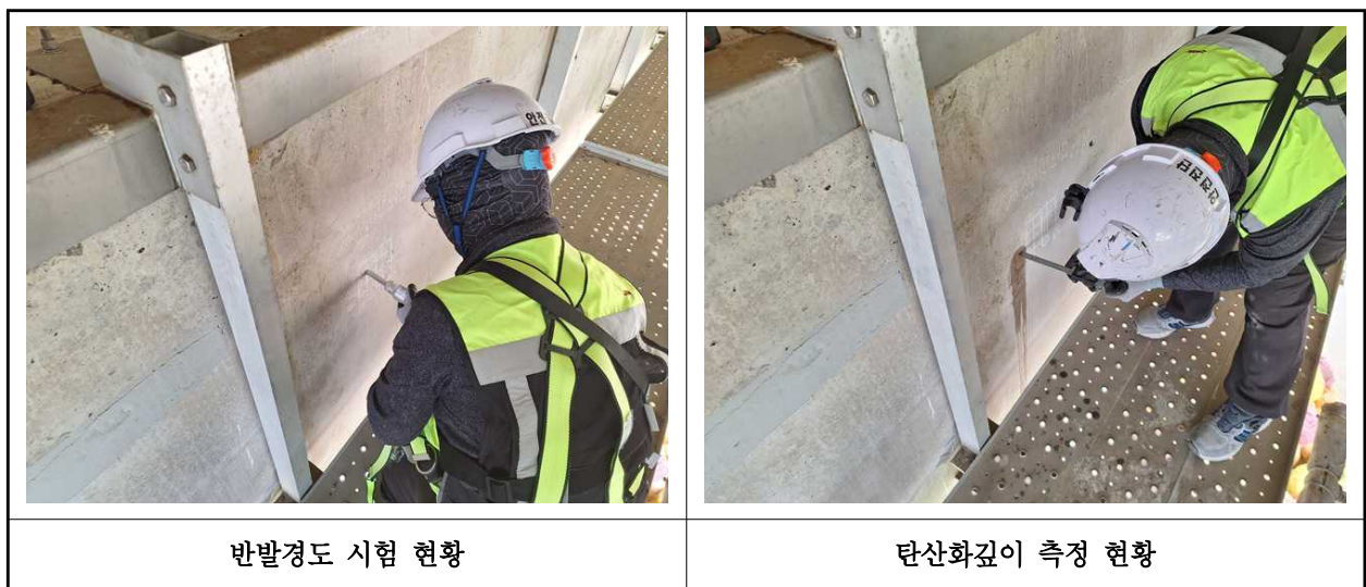
【사진 3.4.1】 콘크리트 내구성조사 현황
