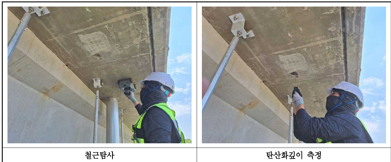
【사진 3.4.3】 탄산화 깊이 측정 현장사진
