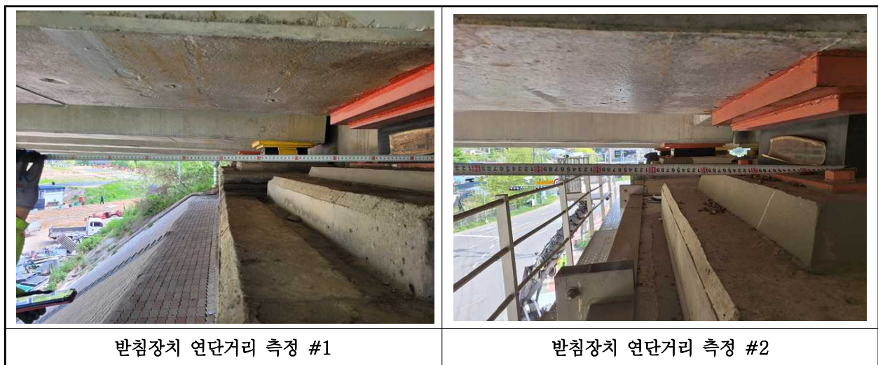
【사진 3.3.15】 교량받침장치 연단거리측정
