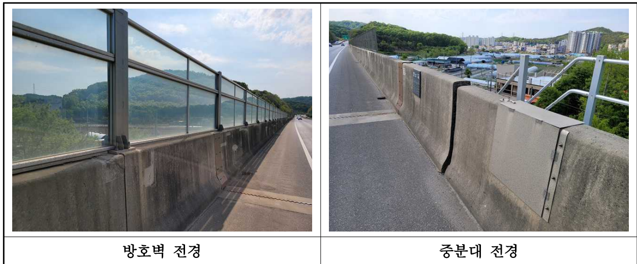
【사진 3.3.24】 방호벽 및 중분대 전경
