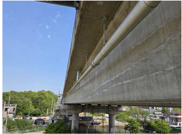
바닥판하면 S2 외측 캔틸레버 상태현황
