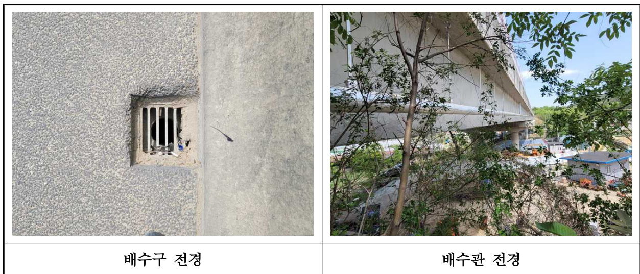
【사진 3.3.22】 배수시설 전경
