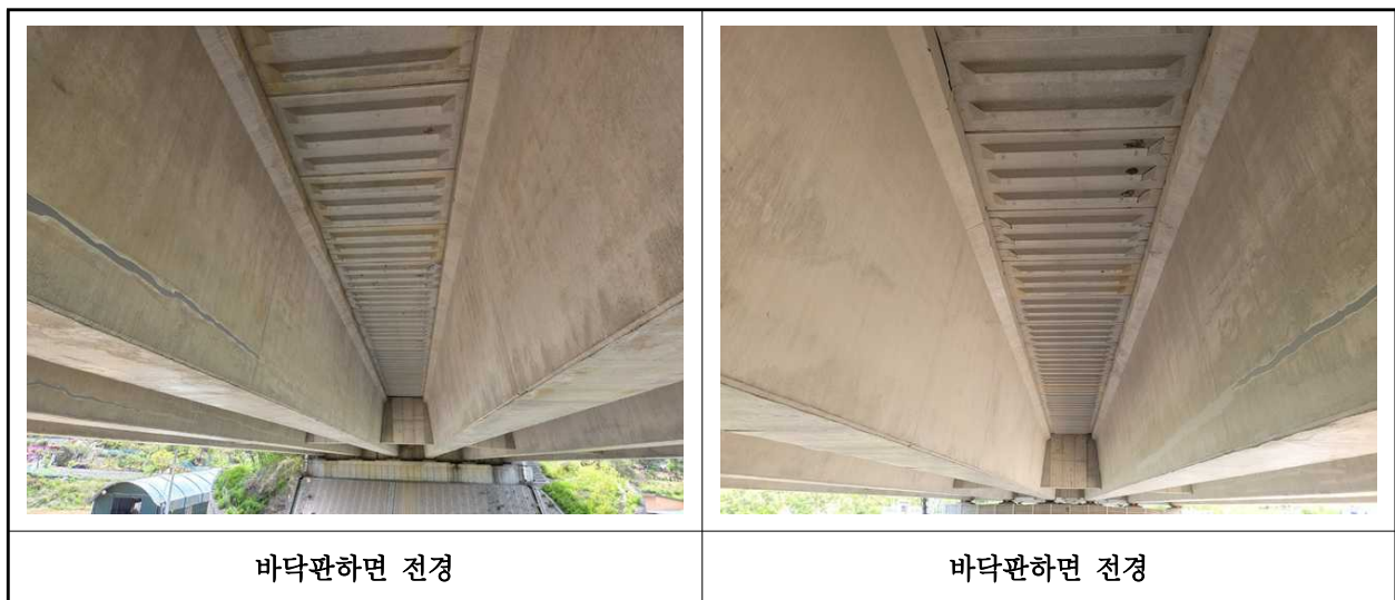
【사진 3.3.2】 바닥판하면 전경
