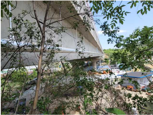
바닥판하면 S1 외측 캔틸레버 상태현황
