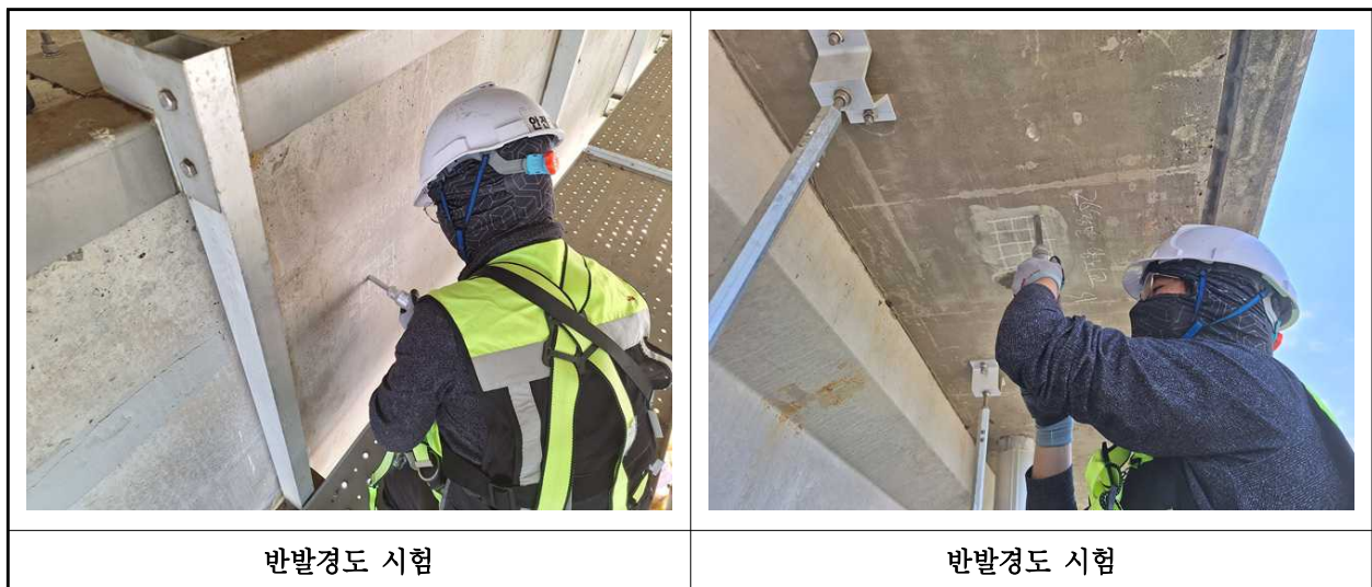
【사진 3.4.2】 반발경도시험 현장사진
