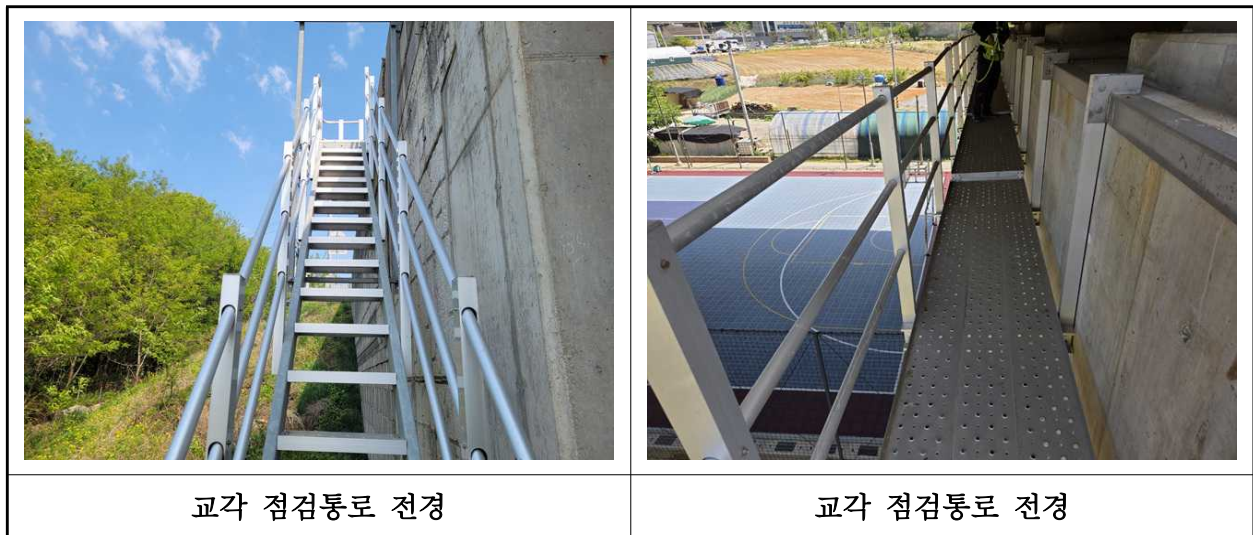
【사진 3.3.26】 교량 점검시설 전경
