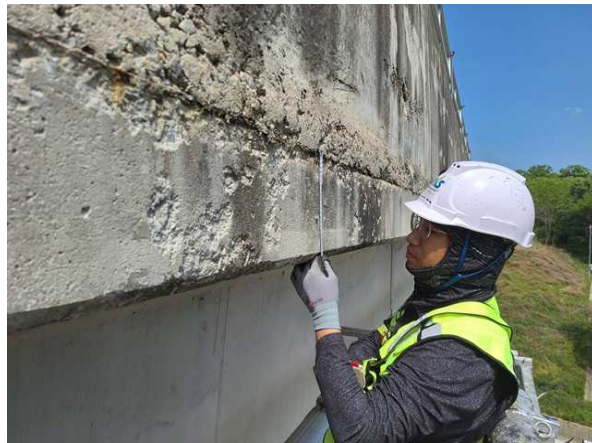
고소작업차를 이용한 부재치수 현장측정
