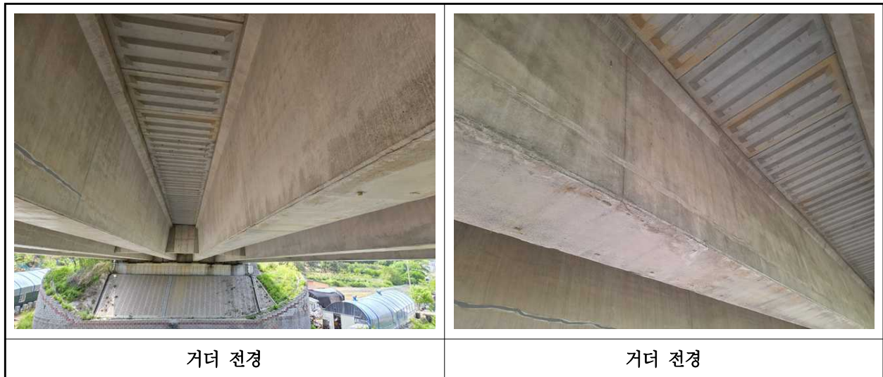
【사진 3.3.4】 거더 전경
