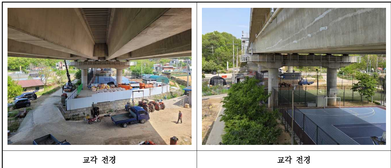
【사진 3.3.10】 교각 전경
