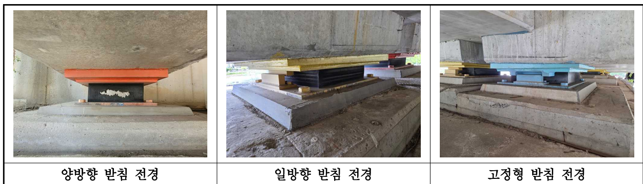
【사진 3.3.13】 교량받침 전경
