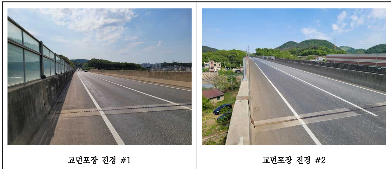
【사진 3.3.20】 교면포장 전경
