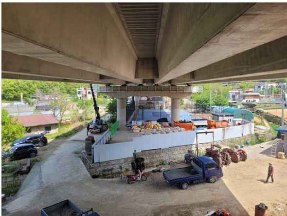
교각 P1 상태현황
